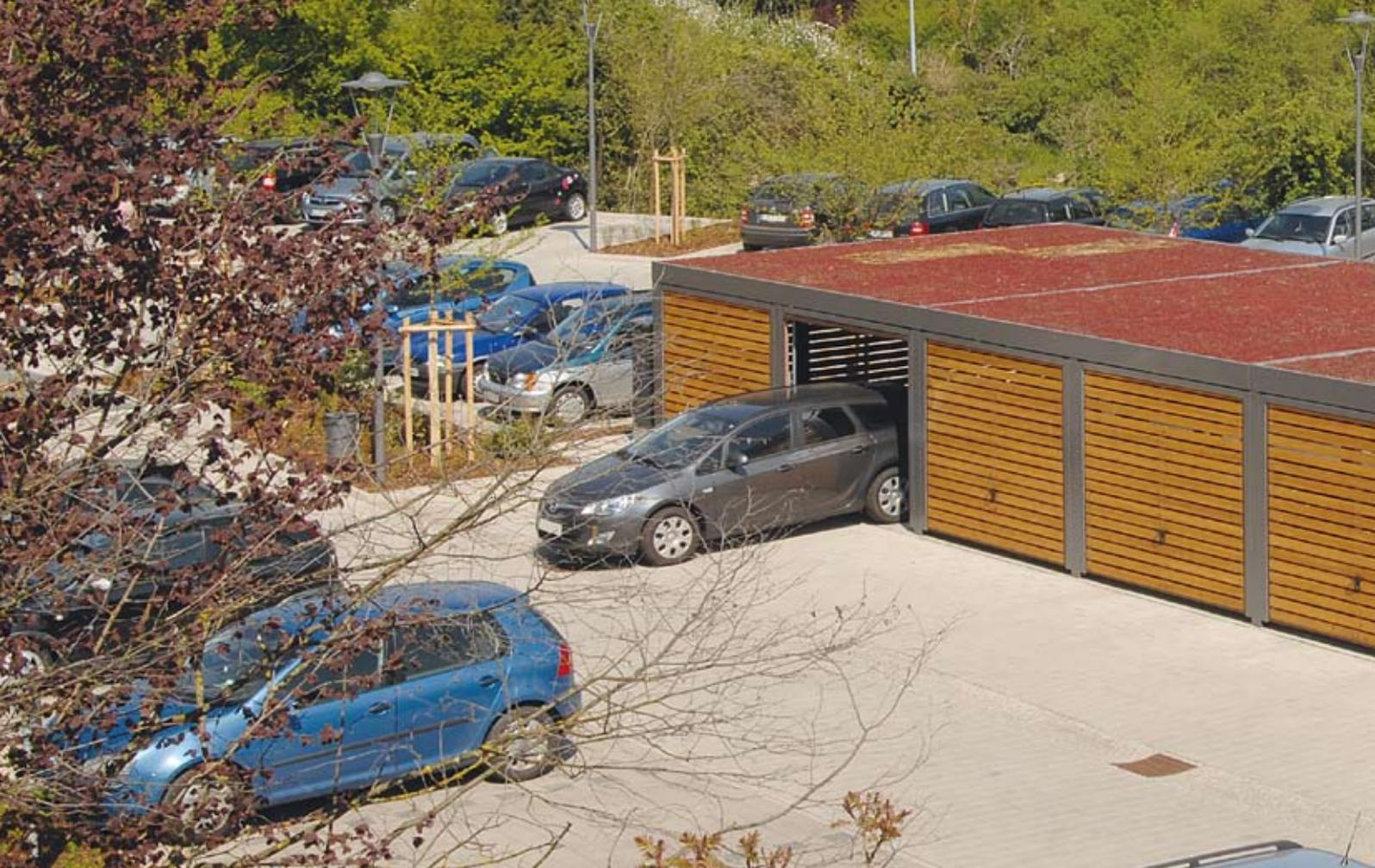
MULTIPOINT Car mit Dachbegrünung, Sonderausführung 18,00 x 6,00 m, für 6 Pkw, Wandelemente und Schwingtore mit Holzbelattung Lärche, Stahlkonstruktion in DB 703 eisenglimmer
