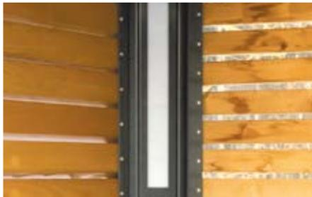
▲ Stützenblende hinterleuchtet mit LED-Lichtleiste
