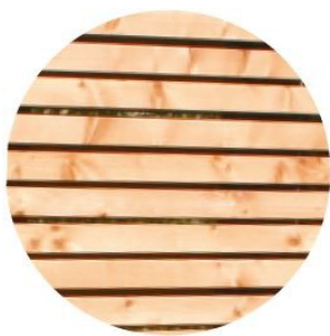
▲ Listwy drewniane poziome, modrzew lazurowany, 55 x 35 mm
