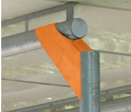
äußerer Stützenkopf farblich abgesetzt
