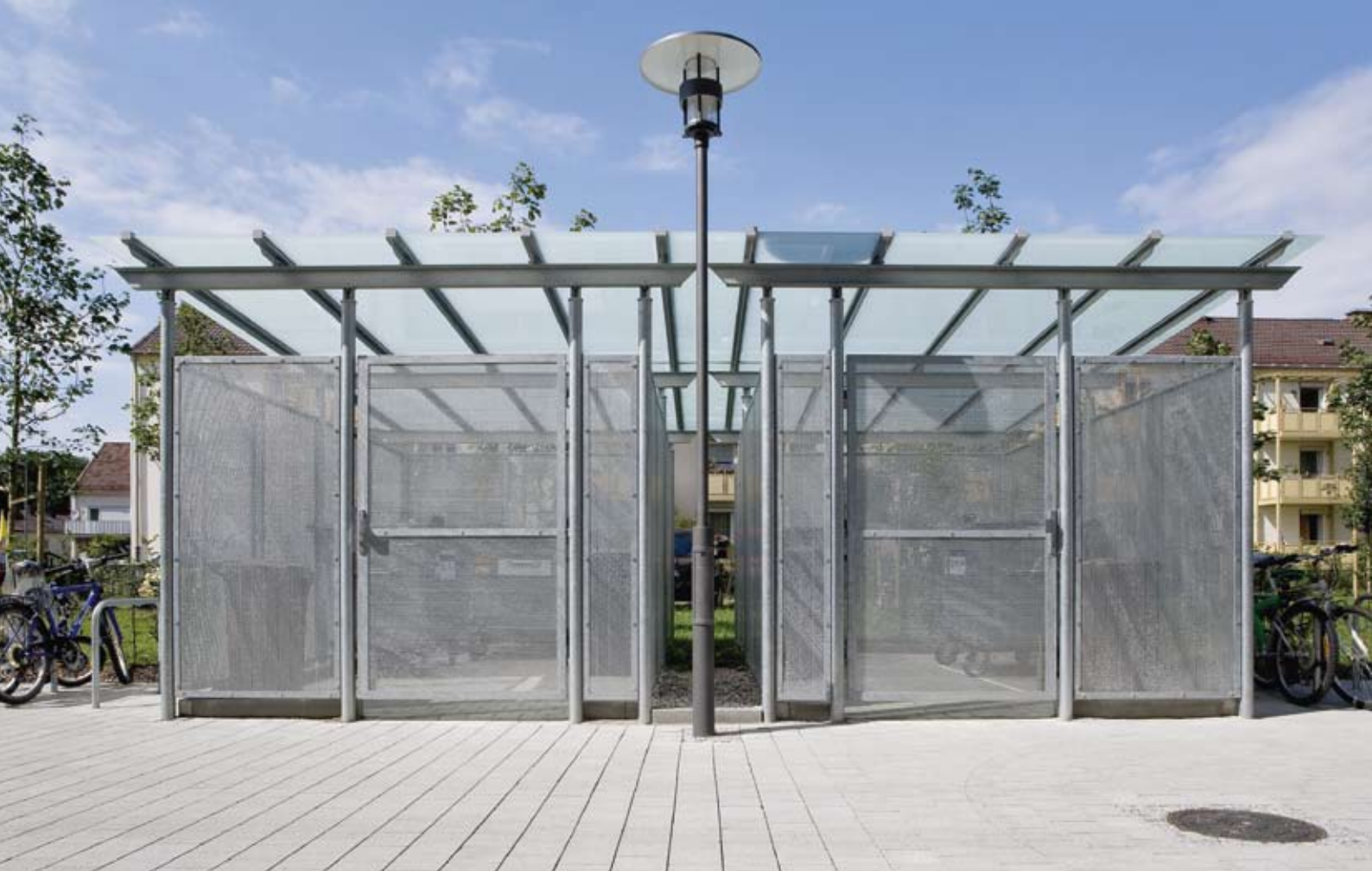
Wertstoffumhausung LYRA, mit Lochblechverkleidung (Sonderhöhe), Dach aus VSG glashell mit matter Folie, Stahlkonstruktion feuerverzinkt
