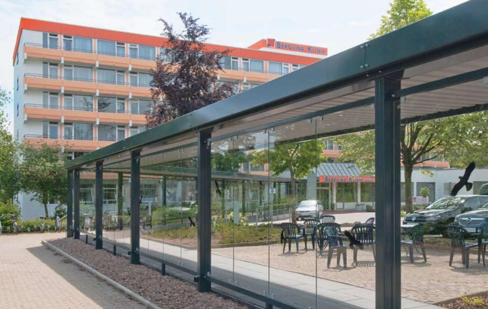
Überdachungsanlage Modell T, als Verbindungsgang, Dachlänge ca. 69 m, Dachtiefe 2,75 m, Stahlkonstruktion in RAL 7016 anthrazitgrau
